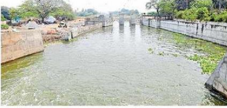
గుడ్లవల్లేరు మండలం కౌతవరం వద్ద బంటుమిల్లి కాలువలో అరకొర పనులు
