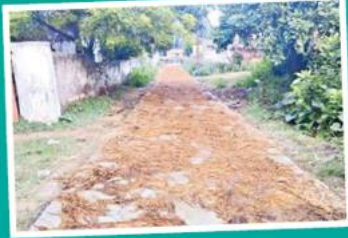
నిర్మాణం పూర్తయిన కౌతవరం రహదారి
