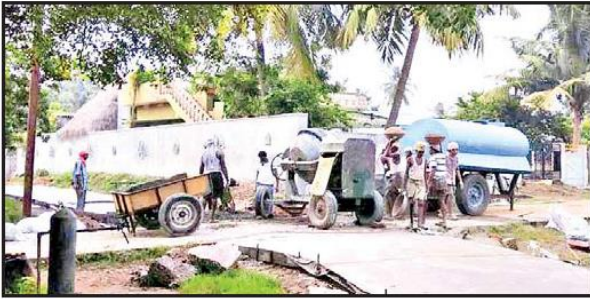
సిమెంట్ రోడ్ల నిర్మాణంలో కార్మికులు
