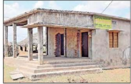
ఏడాదిగా నిలిచిపోయిన నిర్మాణం
