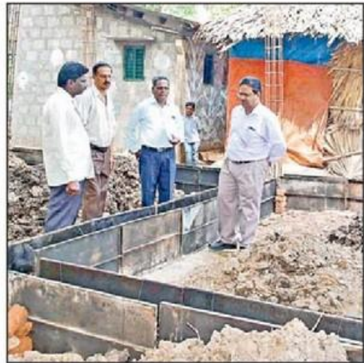
కౌతవరం ఒకటి వార్డులో అంగన్ వాడీ నిర్మాణాన్ని పరిశీలిస్తున్న ఈఈ ఆశోక్ కుమార్
